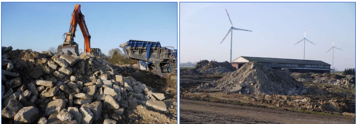
Abb. 14 und 15 Während der Erfassungen lief der Rückbau der Stallanlagen bzw. die Beräumung der Haufwerke.
