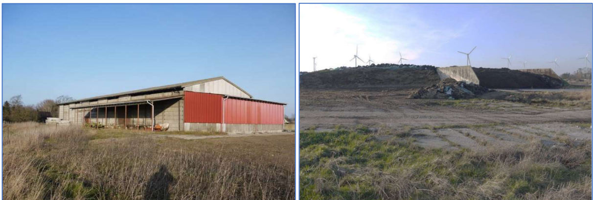
Abb. 12 und 13 Verbleibende landwirtschaftliche Halle und Siloanlage.
